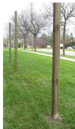
Ajuste el poste si fuera necesario no más de 10 segundos. No mueva el poste de arriba abajo. La expansión terminará en aproximadamente 3-5 minutos y no habrá necesidad de reforzar o sostener el poste después de este lapso (sostenga el poste durante 5 minutos en condiciones de mucho viento). En aproximadamente 15-30 minutos Fast 2K<sup>MC</sup> estará ya bastante duro. Espere cerca de 2 horas para que el producto se fije totalmente antes de instalar la cerca o la puerta.
